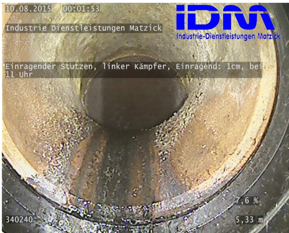
Foto: #2 Entfernung: 5,33 m Code: SE-L Einragender Stutzen, linker Kämpfer, Einragend: 1cm, bei 11 Uhr
